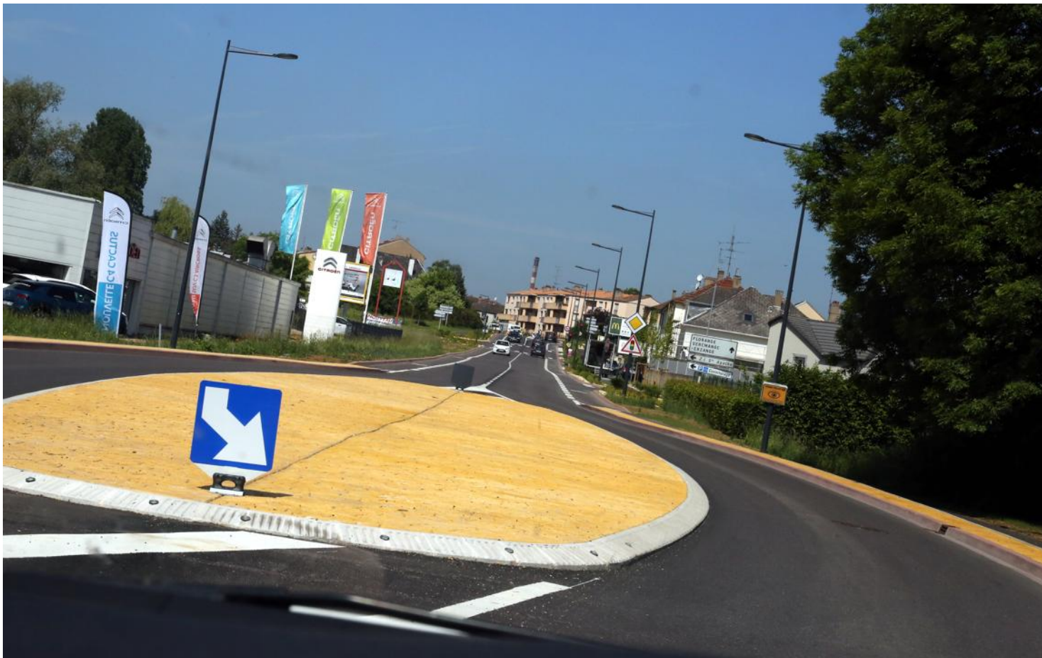
Une chicane a été créée en entrée de ville. Effet recherché ? La réduction de la vitesse à 50 km/h. Photo Julio PELAEZ
