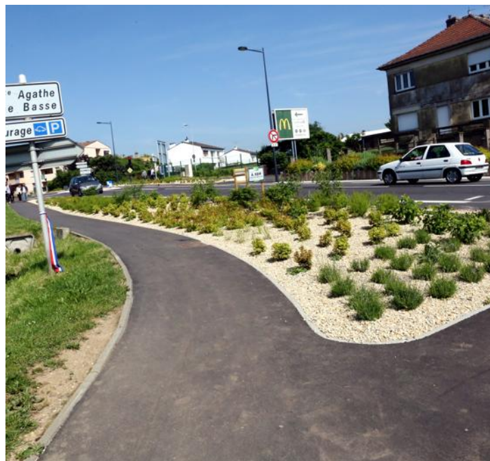
Espaces verts, mobilier urbain... L'aménagement paysager a été repensé. Photo Julio PELAEZ
